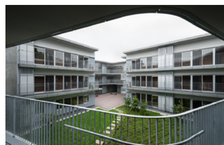
大和町を建て替えた「フロール横浜山手」 撮影：小川重雄
