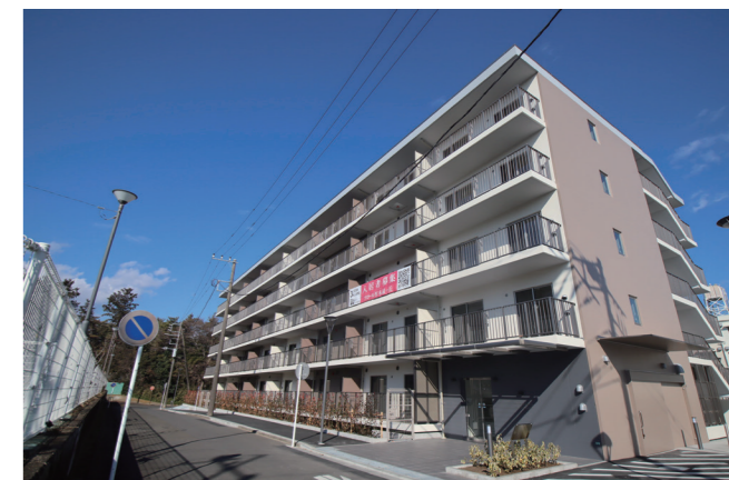
▲2025年1月にフロール厚木緑ヶ丘が竣工しました
