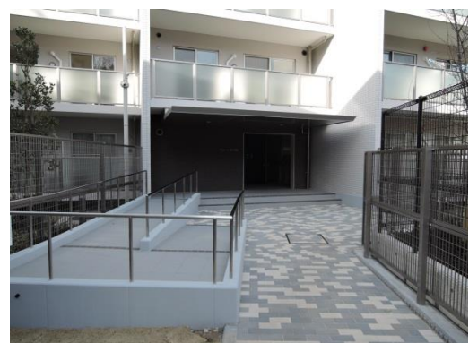
【サブエントランス(3番館)】
