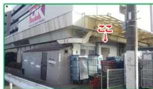
10号棟入口2の写真
